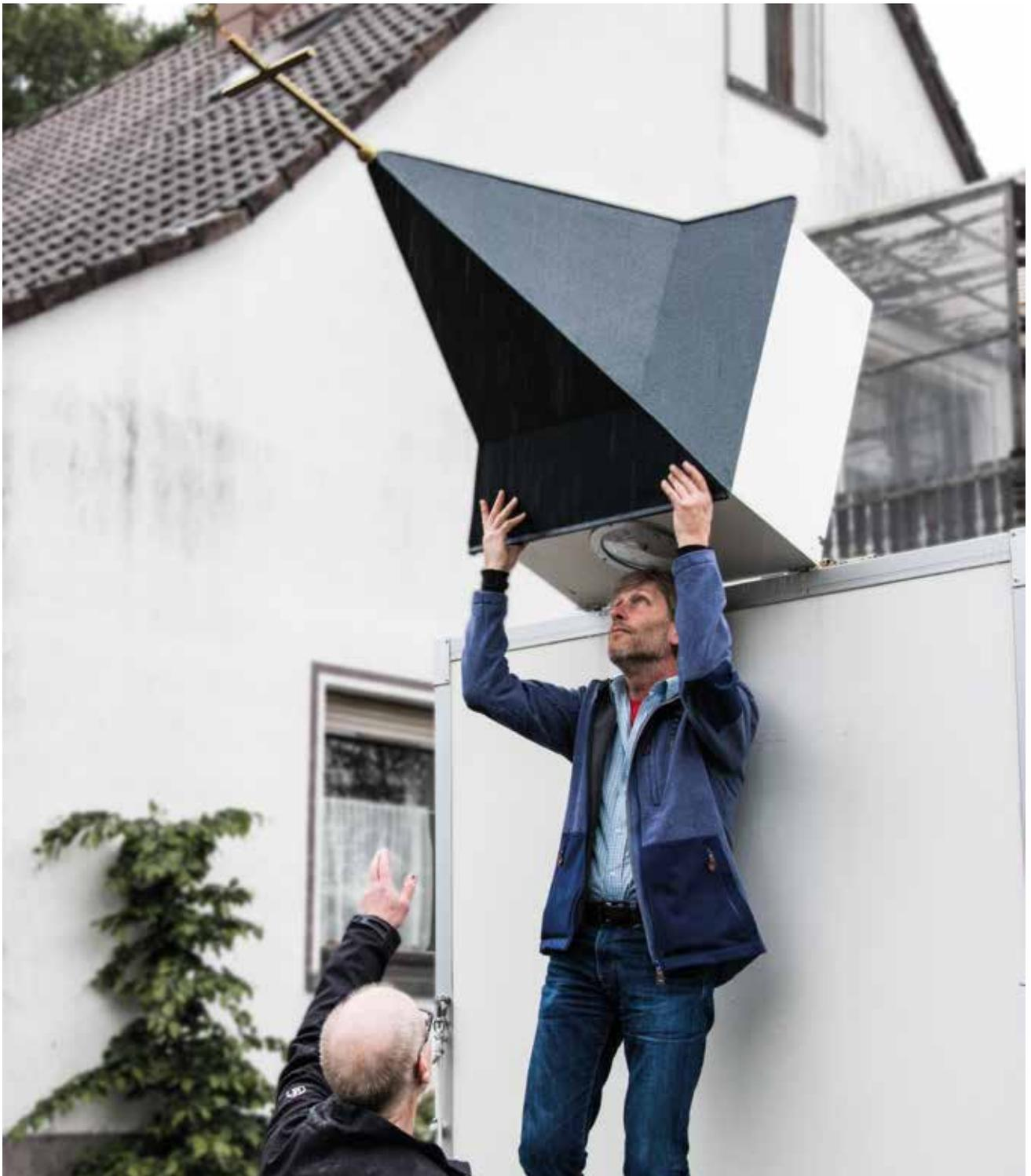
Der Kirchturm wird hochgeklappt. Er wurde extra für die mobile Kirche von einem Schreiner angefertigt.
